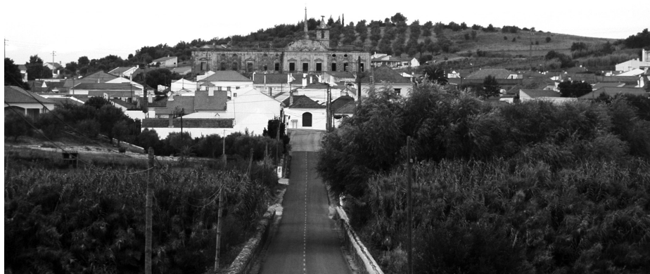
Fig. 9: Eixo de acesso a Manique do Intendente com o palácio-igreja no enfimto.
