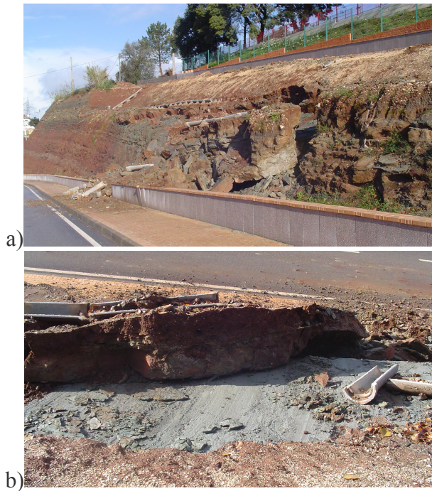
Figura 6. Deslizamento planar no talude Oeste da Escola do Areeiro, ocorrido em Dezembro de 2005. a) Aspecto geral da instabilização que ocorreu segundo uma camada de pelitos na base do termo A2 dos Grés de Silves; b) Bloco deslizado e estrias de movimento na superfície da camada de pelitos.
