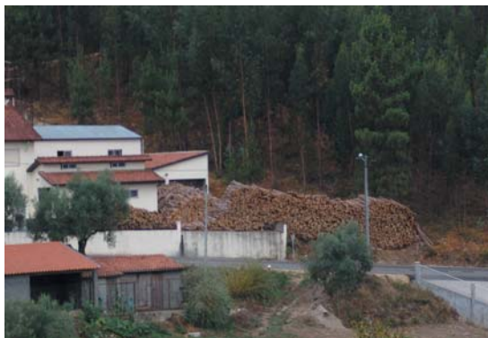
Rot. 2 - Materiais inflamáveis no interior de uma área residencial confinante com espaço florestal.
