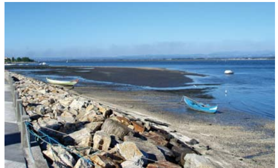
Fot. 2 - Aspecto da deposição recente de materiais na laguna e enrocamento de protecção da esplanada (Torreira, Julho de 2007).
