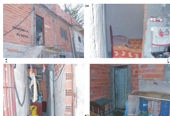
Fot. 2 - (A) autoconstrução; (B) baixa compartimentação interna; (C) instalação elétrica domiciliar precária; (D) gás liquefeito de petróleo - GLP.
