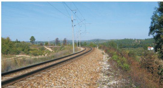
pk 185— sentido Guarda - V. F. das Naves.
