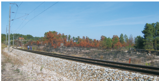
pk 187,7 – sentido Guarda - V. F. das Naves.
