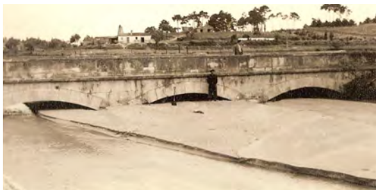
Fot. 5 - Estado de avançado assoreamento do rio Pranto, junto à ponte da Palha, em junho de 1959. Fonte: Arquivo fotográfico do Instituto de Conservação da Natureza e das Florestas.
