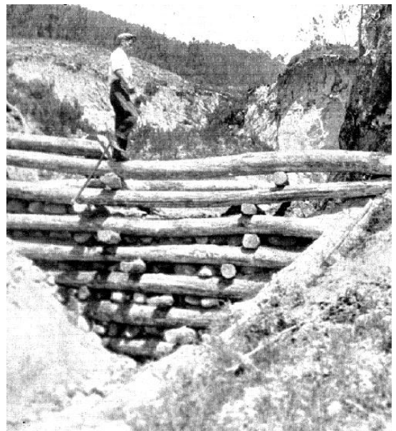
Fot. 9 - Exemplo de uma barragem de madeira e calhau rolado, em construção no ribeiro do Vale do Olharo. Fonte: Ruy MEYER, 1941.
