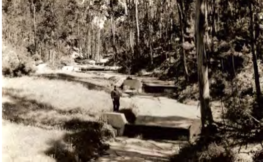
Fot. 7 - Exemplo de construções sucessivas de barragens, no ribeiro do Vale do Travesso, afluente do rio Pranto, no ano de 1960. Fonte: Arquivo fotográfico do Instituto de Conservação da Natureza e das Florestas.
