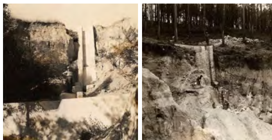
Fot. 22 - Construção de entradas de água em ribeiros afluentes do rio Pranto. À esquerda, no ribeiro do Vale da Parada, em agosto de 1969, e à direita, no ribeiro do Vale do Corso, em 1970. Fonte: Arquivo fotográfico do Instituto de Conservação da Natureza e das Florestas.
