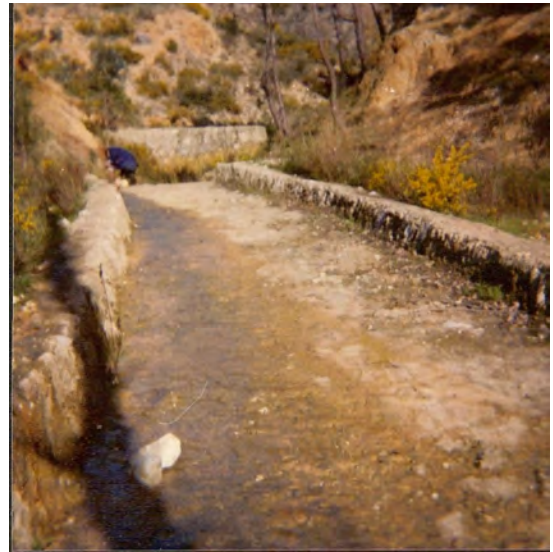
Fot. 8 - Canalete para a condução das águas, também utilizado como caminho para veículos de tração animal. Fonte: José MOTA, 1973.
