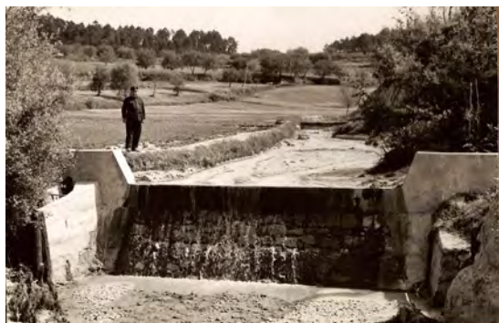
Fot. 11 - Barragem de Alvenaria mista construída no ribeiro do Vale da Parada, afluente do rio Pranto, em abril de 1960. Fonte: Arquivo fotográfico do Instituto de Conservação da Natureza e das Florestas.
