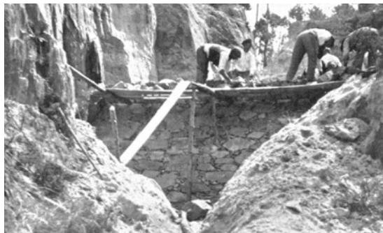
Fot. 10 - Barragem de pedra solta, em fase de construção. Fonte: Ruy MEYER, 1941.
