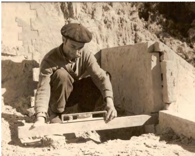
Fot. 19 - Detalhes da montagem de uma barragem de laje escorada, encastrada no terreno . Fonte: M. GALLO, 1942.
