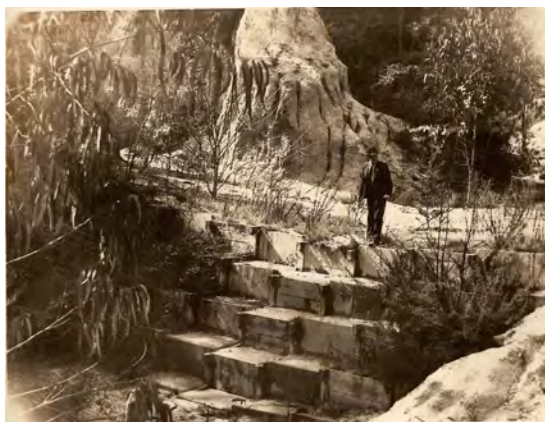
Fot. 16 - Barragem de laje ancorada. Fonte: M. GALLO, 1942.
