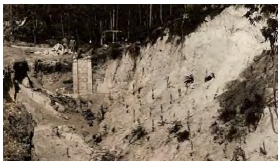
Fot. 21 - Entrada de água em construção no ribeiro do Vale dos Picotos, afluente do rio Pranto, em 1968. Fonte: Arquivo fotográfico do Instituto de Conservação da Natureza e das Florestas.
