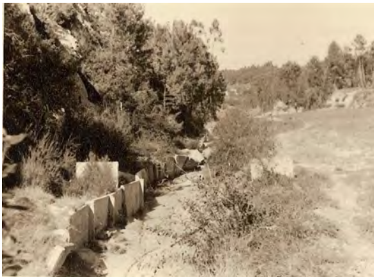
Fot. 23 - Placas de proteção das margens do ribeiro do Vale da Panela, afluente do rio Pranto, em 1959. Fonte: Arquivo fotográfico do Instituto de Conservação da Natureza e das Florestas.
