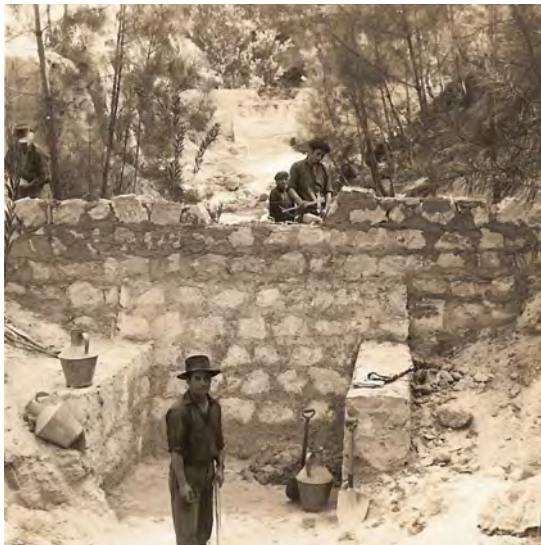
Fot. 12 - Barragem de alvenaria argamassada em construção no ribeiro das cavadas, afluente do rio Pranto, em agosto de 1969. Fonte: Arquivo fotográfico do ICNF.
