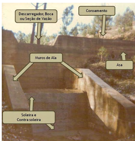
Fig. 3 - Constituintes principais das barragens de correção torrencial. Fonte: Adaptado de J. MOTA, 1973.
