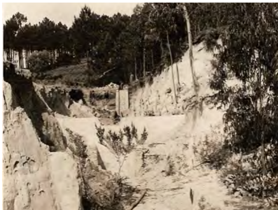
Fot. 13 - Barragem de alvenaria argamassada em fase de construção no ribeiro dos Picotos II, afluente do rio Pranto, em agosto de 1968. Fonte: Arquivo fotográfico do ICNF.
