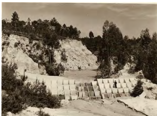
Fot. 18 - Barragem de Lage escorada no Ribeiro do Vale da Miguelueta, afluente do rio Pranto, em 1960. Fonte: Arquivo fotográfico do Instituto de Conservação da Natureza e das Florestas.
