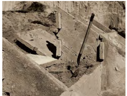
Fot. 19 - Detalhes da montagem de uma barragem de laje escorada, encastrada no terreno . Fonte: M. GALLO, 1942.
