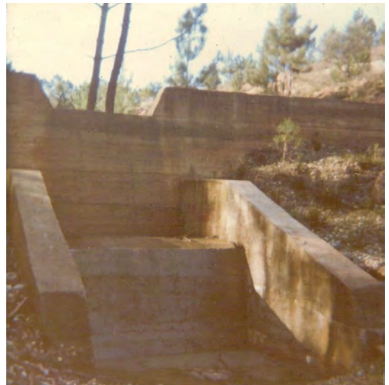
Fot. 14 - Barragem de Betão com soleira e contra soleira. Fonte: J. MOTA, 1973.
