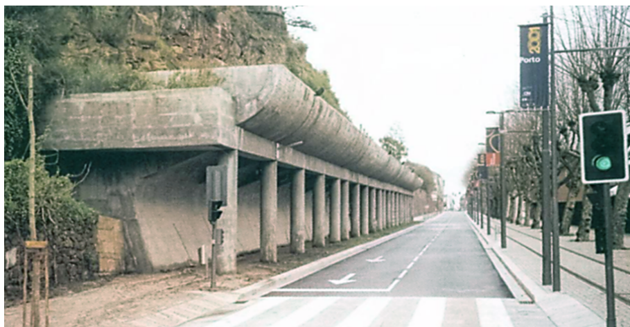
Fot. 14 - Rua da Restauração, Porto - prevenir crises provocadas por desabamentos (obras terminadas em janeiro de 2001 - fotografia extraída de F. REBELO, 2001 b).
