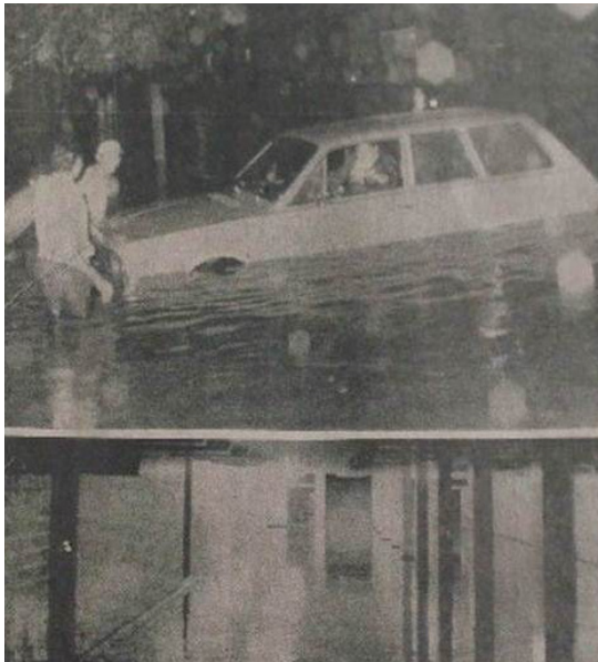
Fot. 1a- Inundação na rua Dr. Malcher.
