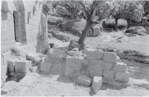
Fig. 4: Estrutura perpendicular ao alçado S da ermida (DGEMN: Arquivo).
