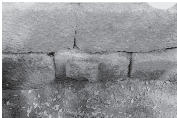
Fig. 3: Silhar almofadado incorporado na parede exterior S da ermida (DGEMN: Arquivo).
