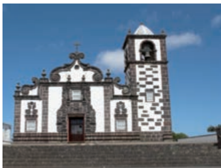
Fig. 3 – Património edificado: igreja de Nossa Senhora da Purificação em Santo Espírito, Ilha de Santa Maria (Eva Lima).
