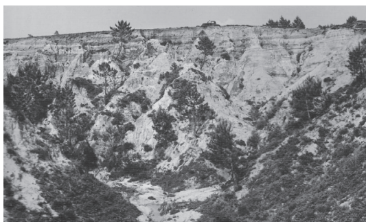
Fotografia 9 Efeitos da erosão no ribeiro do Vale da Sobreira. Fonte: Mário GALLO, 1942a).
