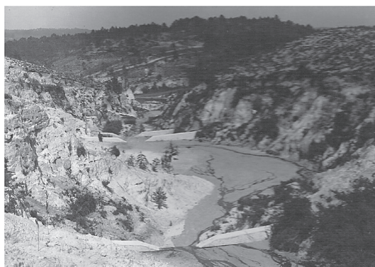
Fotografia 15 Ribeiro das Figueiras, afluente do ribeiro dos Milagres. Correção com barragens de alvenaria. Fonte: Mário GALLO, 1942a
