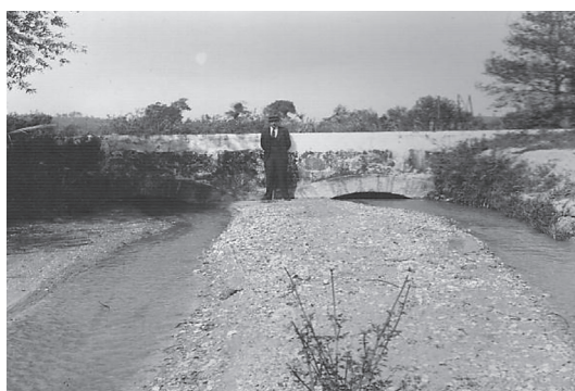
Fotografia 8 Assoreamento do ribeiro do Casal Cabrito, junto à ponte da estrada de Leiria a Figueira da Foz. Fonte: Mário GALLO, 1942a.
