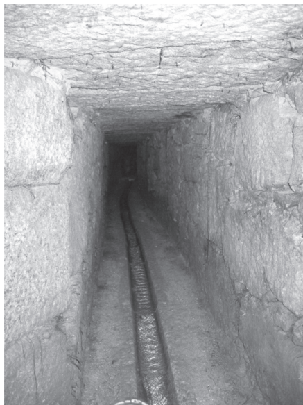
Fig. 14 – Lafões. Abadia Cisterciense. Canal subterrâneo de adução de água potável. Fotog. Virgolino Jorge
