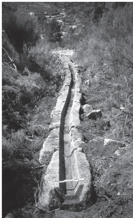
Fig. 12 – Tarouca. Abadia Cisterciense. Troço superficial de adução de água potável (Quinta do Lavatório). Notar a secção transversal da caleira em V aberto. Fotog. Virgolino Jorge
