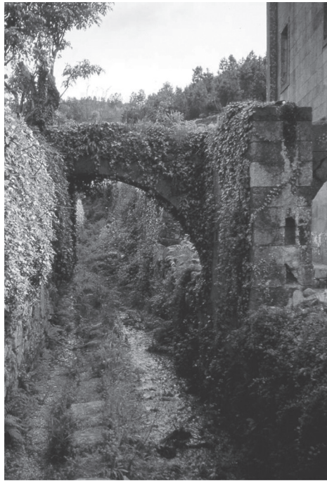
Fig. 18 – Tarouca. Abadia Cisterciense. Troço em escada de adução de água potável. Fotog. Virgolino Jorge
