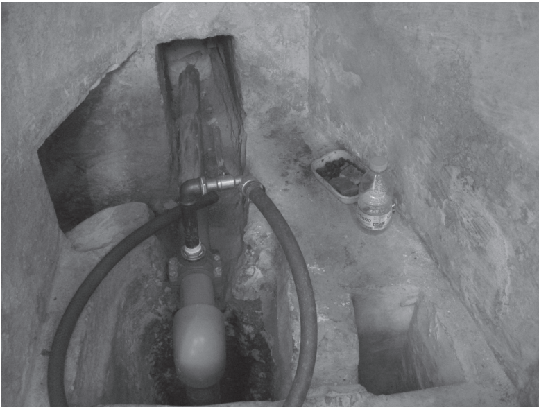
Fig. 20 – Alcobça. Abadia Cisterciense. Tanque de compensação, embebido na parede meridional da igreja. Fotog. Virgolino Jorge
