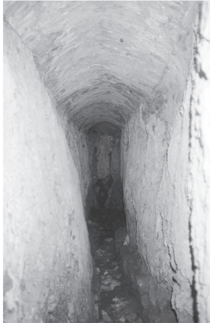
Fig. 27 – Almoester. Abadia Cisterciense. Conduta de evacuação de águas usadas. Fotog. Virgolino Jorge
