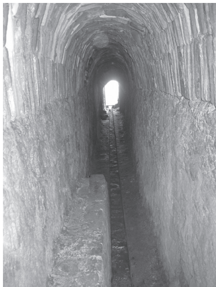
Fig. 13 – Alcobaça. Abadia Cisterciense. Troço subterrâneo de adução de água potável. Fotog. Virgolino Jorge
