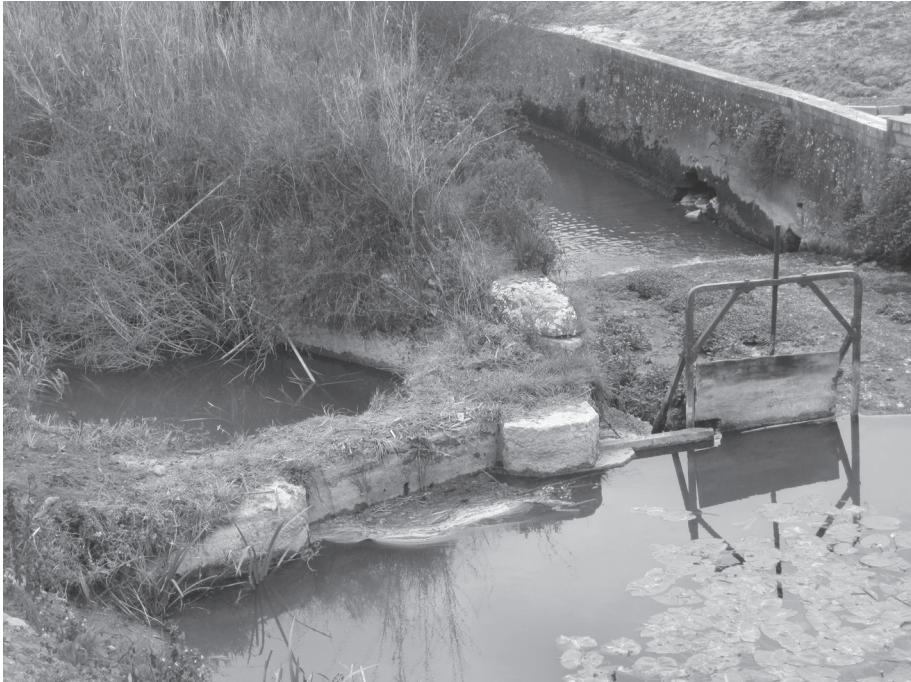
Fig. 25 – Alcobaça. Abadia Cisterciense. Açude para captação de água comum, no rio Alcoa. Fotog. Virgolino Jorge
