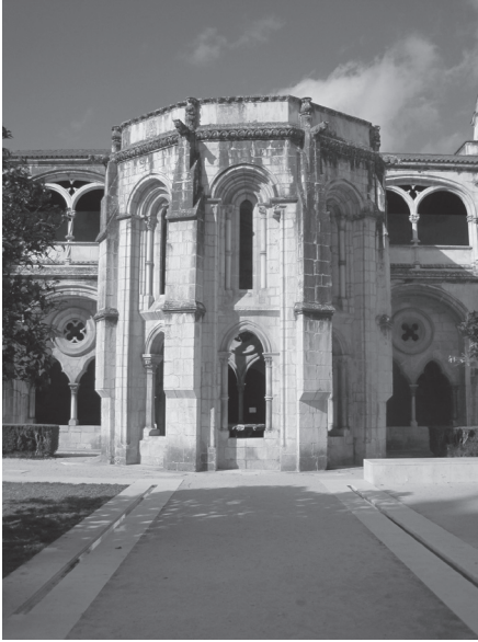
Fig. 21 – Alcobaça. Abadia Cisterciense. Exterior da casa do lavatório. Fotog. Virgolino Jorge
