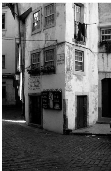
Fot. 3 – Rua Sargento-Mor, Coimbra: o piso, sucessivamente levantado pela deposição de sedimentos, foi obrigando a reduzir a dimensão das portas das casas mais antigas. Foto: F. Rebelo, 1996.
