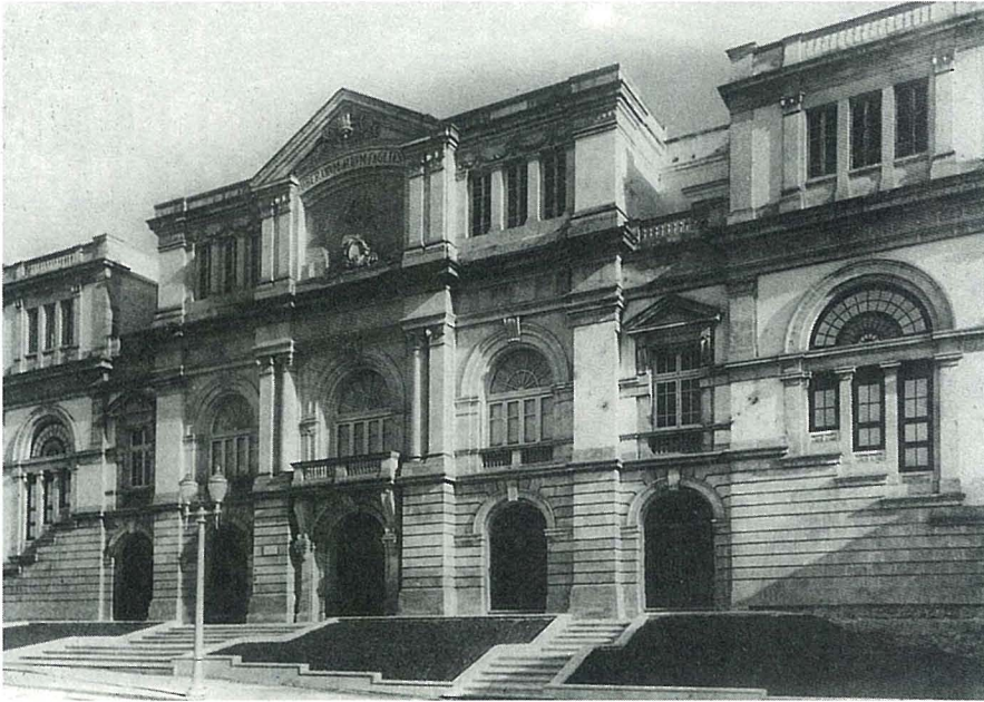
Foto 1 – Aspecto da fachada principal do antigo edifício da Faculdade de Letras, onde começou por funcionar o Instituto de Estudos Clássicos.
