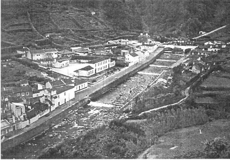
Fot. 49 - Povoação. Canal de escoamento torrencial melhorado com obras de engenharia (1979).
