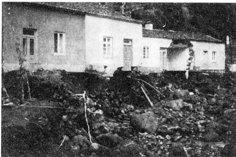
Fot. 33 - Consequências do trabalho de sapa realizado pelas águas, em margem côncava, no Faial da Terra. A estrada desaparece pela acção das águas da cheia. Localização: Ver Fig. 28 - 6.
