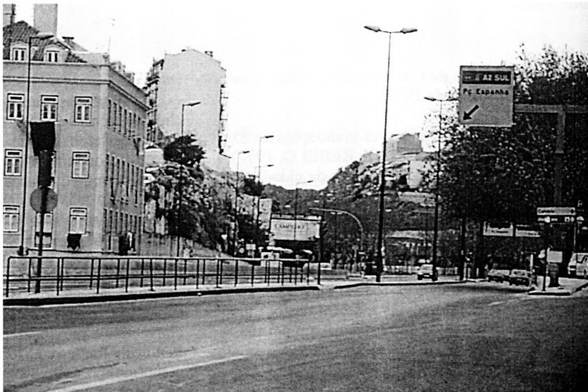
Fot. 34 - Aspecto da parte terminal do canal de escoamento da torrente de Alcântara (Lisboa).
