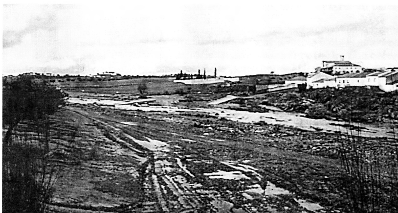
Fot. 38 - Ponte destruída em Albernoa.
