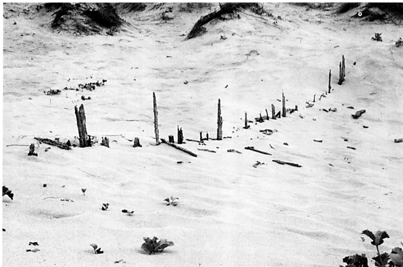
Fot. 12 - Vestígios de estacaria de madeira colocada nas dunas de S. Pedro de Moei pelos finais do séc. XIX.
