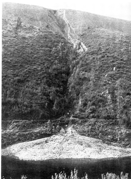
Fot. 18 - Forma torrencial de pormenor na margem esquerda do Rio Vouga, originada pela concentração da escorrência a partir de um ponto em aterro preparado para a construção do IP 5. (Fotografia tirada nos anos 80 e gentilmente cedida pelo Dr. Enio Semedo. Fotografia semelhante, mas relativa ao IP4, foi publicada por A. PEDROSA, 1994)
