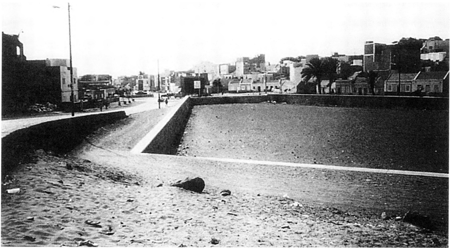
Fot. 46 - Mindelo — leito de ribeira cortado para jusante por muro e casas.
