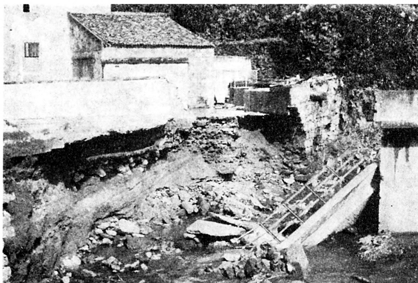
Fot. 31 - Conseqüências do trabalho de sapa das águas na margem direita da ribeira dos Lagos (Povoação). Localização: Ver Fig. 27-4.
