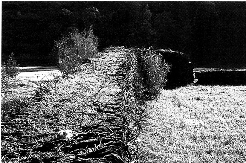
Fot. 27- Mondego na travessia do Maciço Marginal de Coimbra (margem direita) - pormenor de um muro transversal em xisto construído sobre o leito de inundação.
