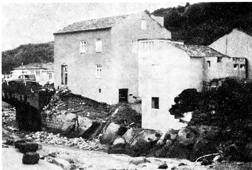
Fot. 30 - Conseqüências do trabalho de sapa das águas na margem direita da ribeira do Purgar (Povoação). Localização: Ver Fig. 27-3.
