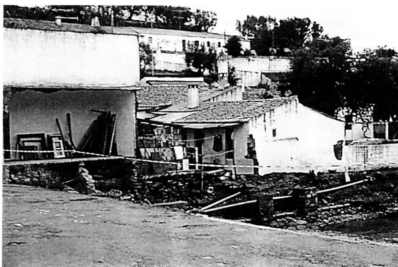
Fot. 39 - Garvão. Casas danificadas pelas águas da cheia após a destruição das placas de cimento da margem esquerda da ribeira canalizada a céu aberto. Fotografia tirada de cima da ponte, ela própria também em parte destruída.
