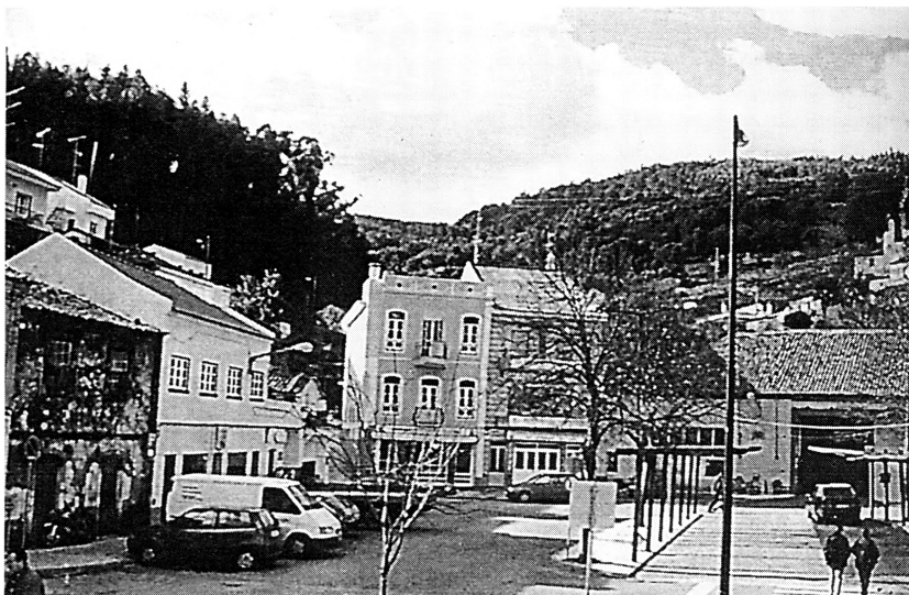
Fot. 36- Casas do centro de Monchique, já recuperadas da inundação, mas mantidas no mesmo local, sobre o leito da ribeira.
