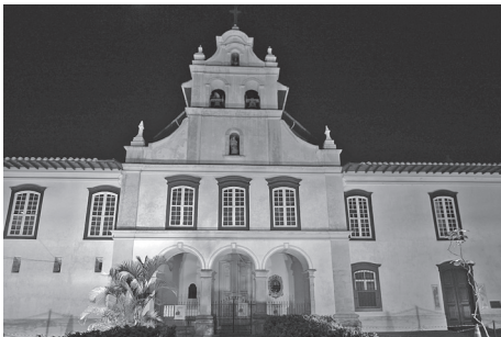
Figure 1 – Mosteiro da Luz, São Paulo, Brazil. Front view. All photos by L. R. Fontes.
