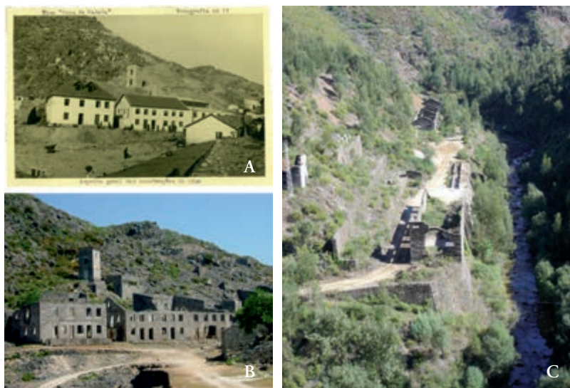
Fig. 2 – Nas fotos A e B podemos observar o confronto entre a realidade do estado dos escritórios e oficinas da mina de Regoufe, no ano de 1943 (fonte: Arquivo de Minas da DRE do Norte) e na atualidade, sendo notório o estado atual de avançada degradação destas infraestruturas. A foto C, à direita, é uma fotografia com vista panorâmica das ruínas do couro mineiro de Rio de Frades do estado atual das instalações técnicas, lavaria, tanques de decantação e oficinas.
