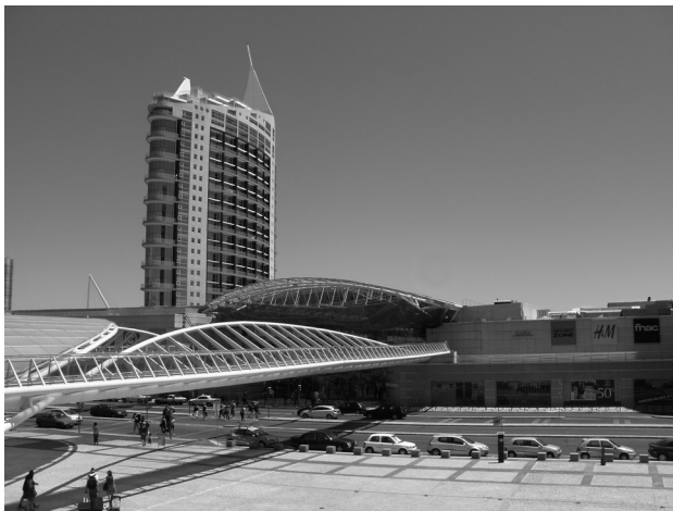
Figura 1. Espaço urbano requalificado, no contexto da Expo 98, em Lisboa (2011)
