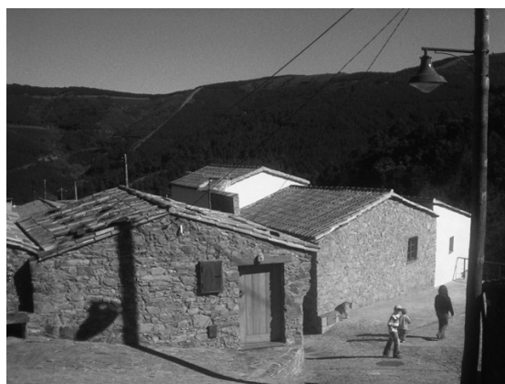
Figura 1. Imóveis particulares recuperados e espaços públicos requalificados no âmbito do PAX, em Gondramaz (Miranda do Corvo, 2008)
