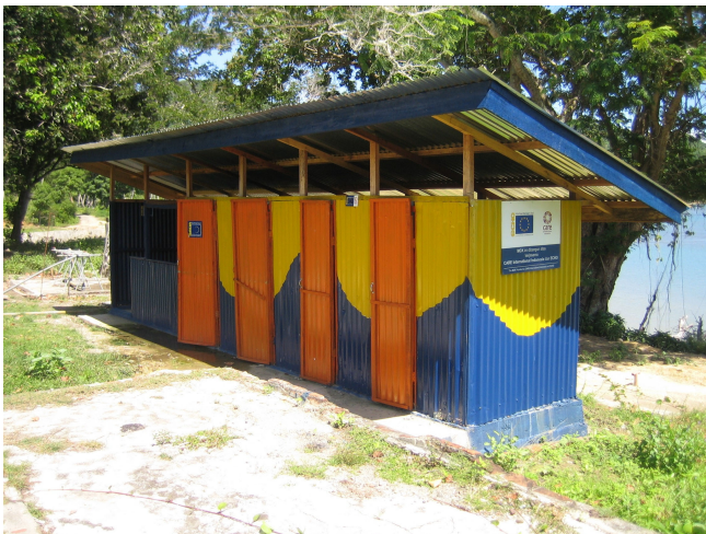
Assistência sanitária: latrinas em Aceh, Indonésia (Fonte: TCE)
